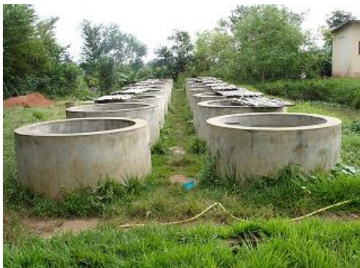
(A) Bassin aquacole hors-sol en béton à l'URZH (FAST/UAC, Abomey-Calavi)
