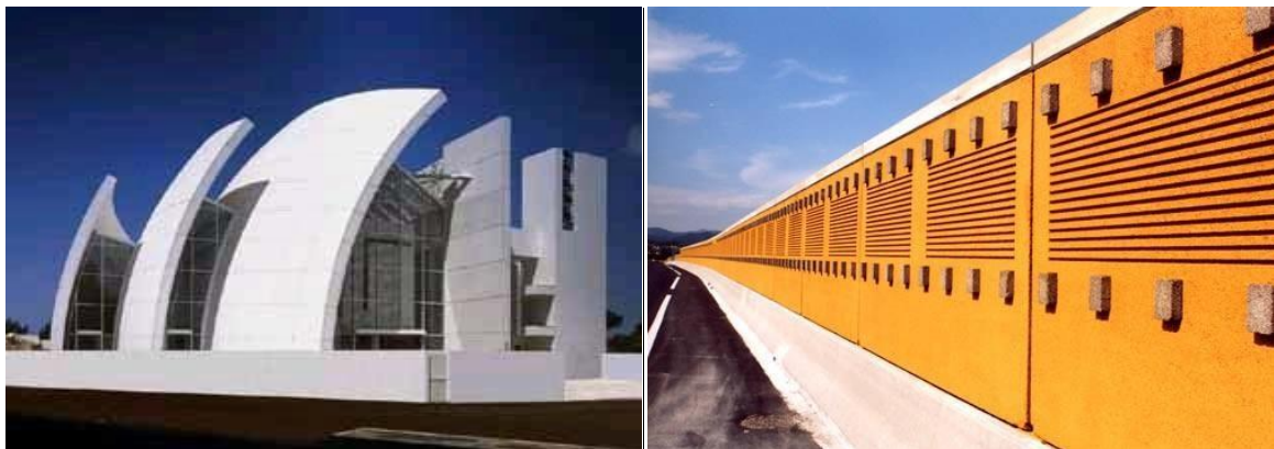
Figure I.15 Eglise de Jubilé, ROME et un mur anti bruit en béton auto-nettoyant [29].
