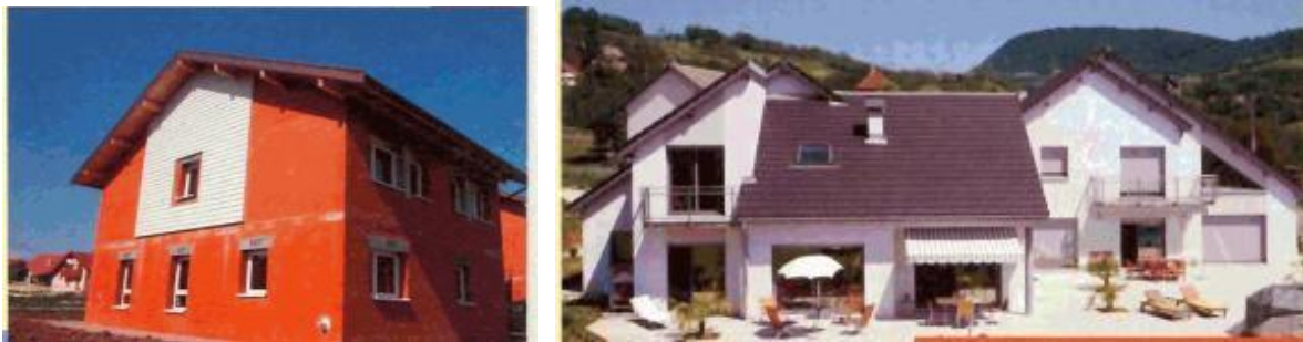
Figure II.14 La couverture des toitures
